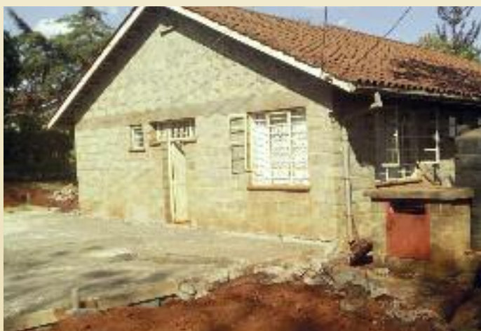
Suor Alice nello scavo fatto, le nuove fondamenta e l'inizio della costruzione
