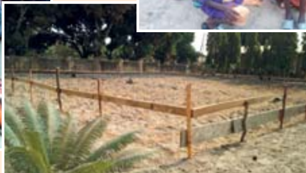
Scavo per nuovo laboratorio
