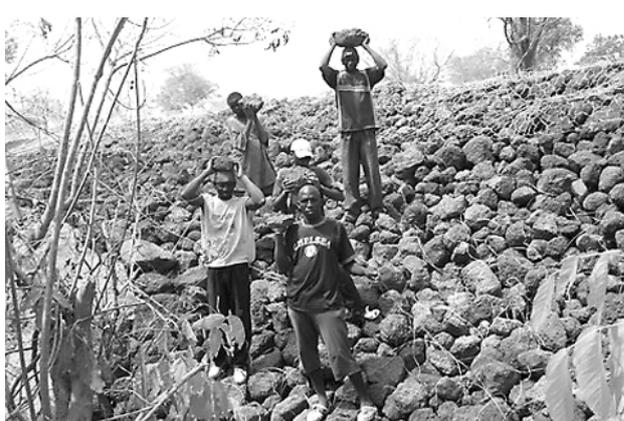
Gli operai (presso ogni diga!) recuperano, portandoli a spalla o in testa, i sassi necessari per riempire i gabbioni di rete metallica che costituiranno la diga.
