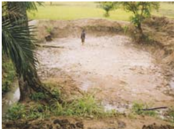
La vasca per allevamento pesci è stata scavata, aspetta l'acqua e gli avanotti (Togo - Tchebebe)
