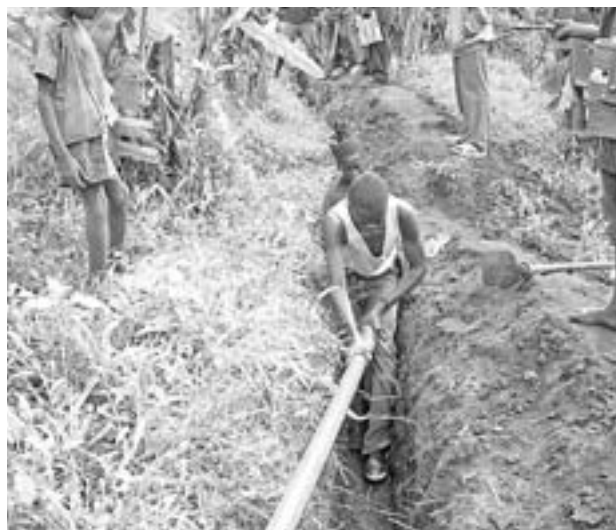
RYAKABAMBA - Burundi Acquedotto p. Minazzi - Micro M. 965 del 2009 finito e funzionante
