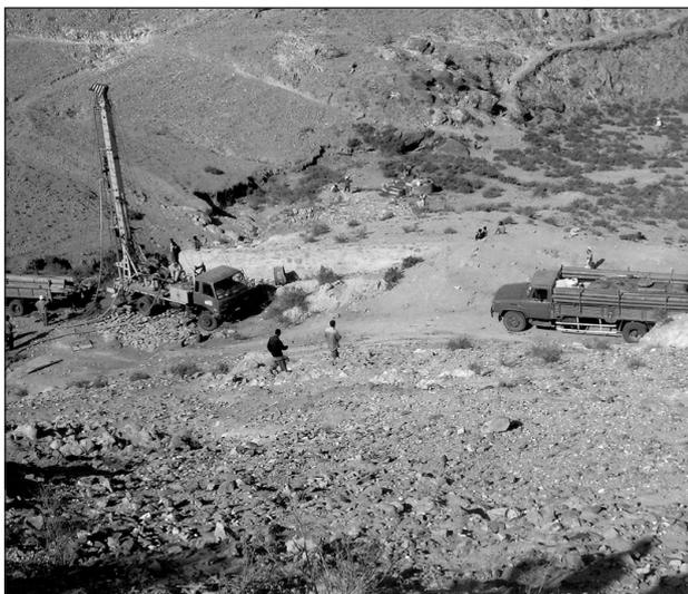
M. 907 - Vista dall'alto del cantiere con la trivella ed i camion: l'acqua è stata trovata a 69 metri di profondità nella prima perforazione, e a 45 metri in una seconda perforazione. I due pozzi assieme garantiscono 30 litri al minuto, sufficienti per la popolazione ed il bestiame, anche se le varie frazioni componenti il villaggio si trovano più in alto. L'eventuale realizzazione di pompe e vasche per portare più in alto l'acqua resterà a carico della popolazione e dei Padri eritrei.
